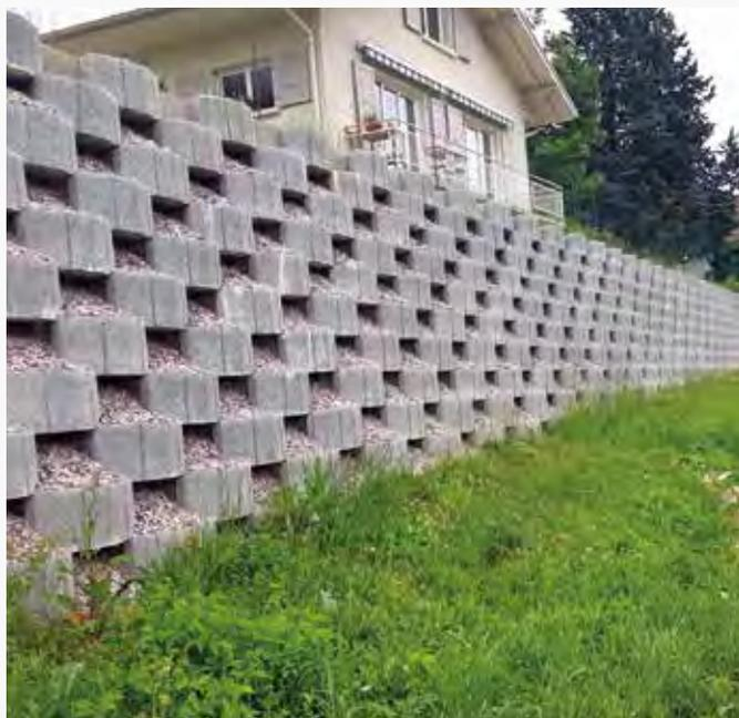
Le concept TALUROC® est un système de soutènement adapté à la plupart des situations : terrain difficile, pente abrupte ou forte charge sur le talus à soutenir.
